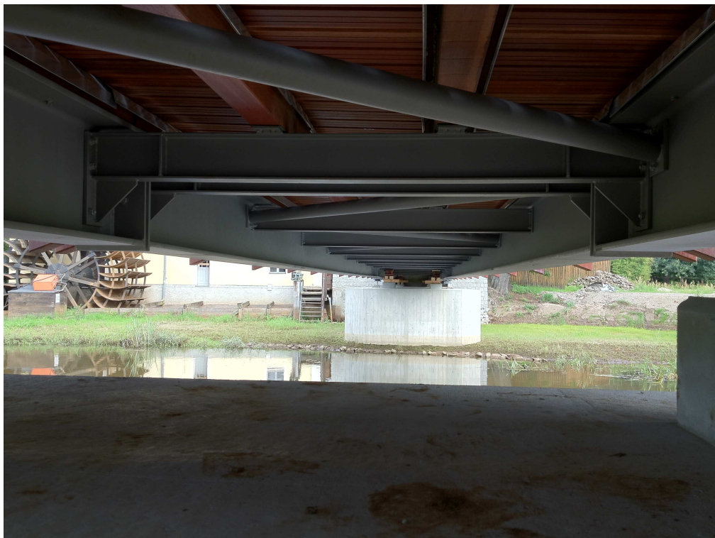
Geh- und Radwegbrücke Plessa
